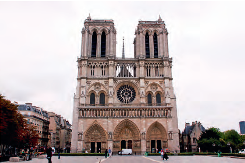
巴黎圣母院 1163 年 法国巴黎 巴黎圣母院是一座较为典型的哥特式建筑。门、窗和塔楼都是随处可见的尖顶形状，建筑正面的两个塔楼高 60 多米，屋顶正中间的尖塔高达 106 米，整个建筑都强调直线上升，窗户装饰着彩色镶嵌玻璃，光彩瑰丽。2019 年巴黎圣母院意外失火，导致塔尖部分被破坏，目前正在修缮中。
