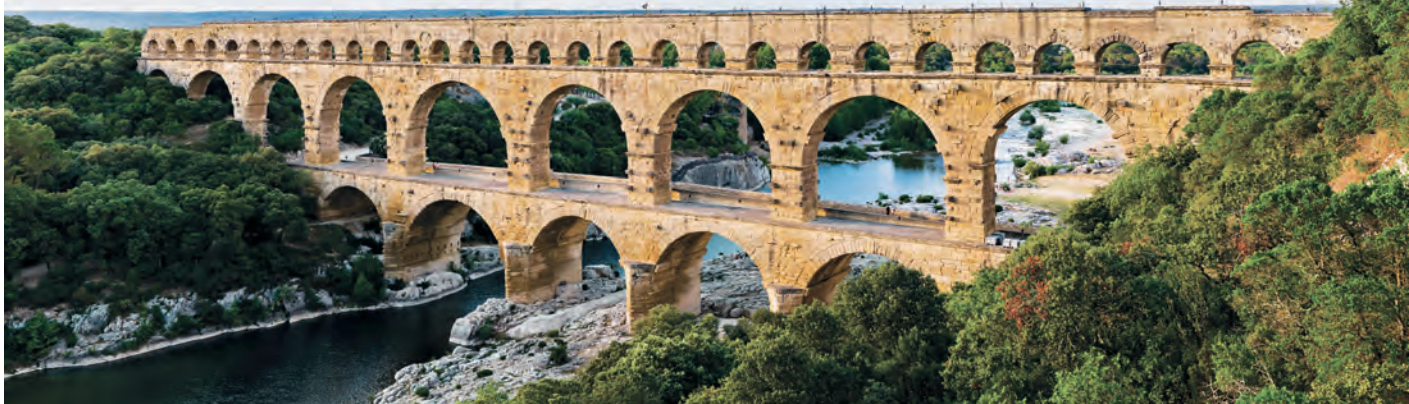
加尔桥 古罗马 长 269 米，高 49 米 法国南部尼姆城郊 三层的石头拱形桥，是古罗马修建的高空引水渡槽，也是现存最早的巨型拱结构输水道。
